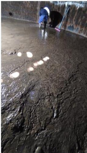
**FIGURA 1:** RESÍDUO INTERNO CONTIDO NO RESERVATÓRIO.
