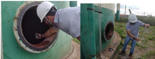
FIGURA 4: MEDIÇÃO DE GASES ANTES DA ENTRADA DOS COLABORADORES.
