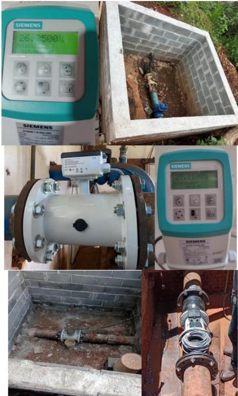
FIGURA 10 - INSTALAÇÃO DE MACROMEDIDORES
