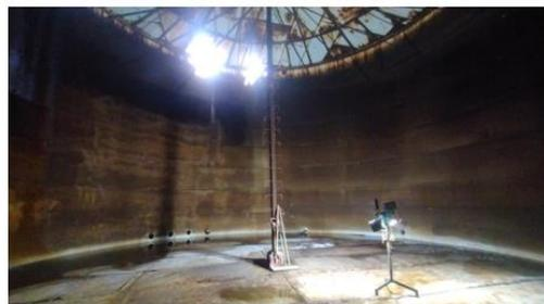
FIGURA 4: RESERVATÓRIO INTERNO APÓS A LIMPEZA E HIGIENIZAÇÃO.
