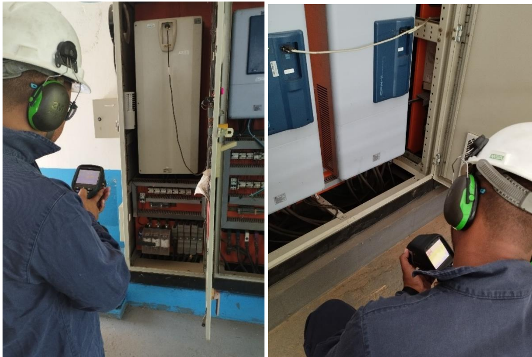
Figura 1. Inspeção termográfica em painel elétrico.
