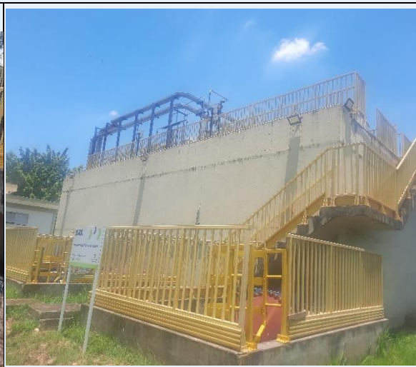
Figura 22: Vista lateral do tratamento físico-químico
