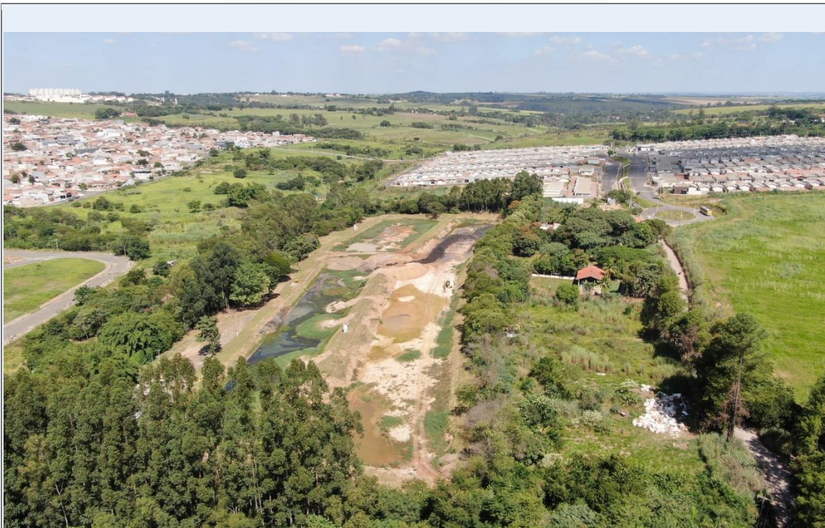
Figura 25: Imagem drone das lagoas (abr/24)
