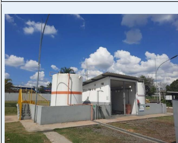
Figura 14: Sistema de geração de Dióxido de Cloro
