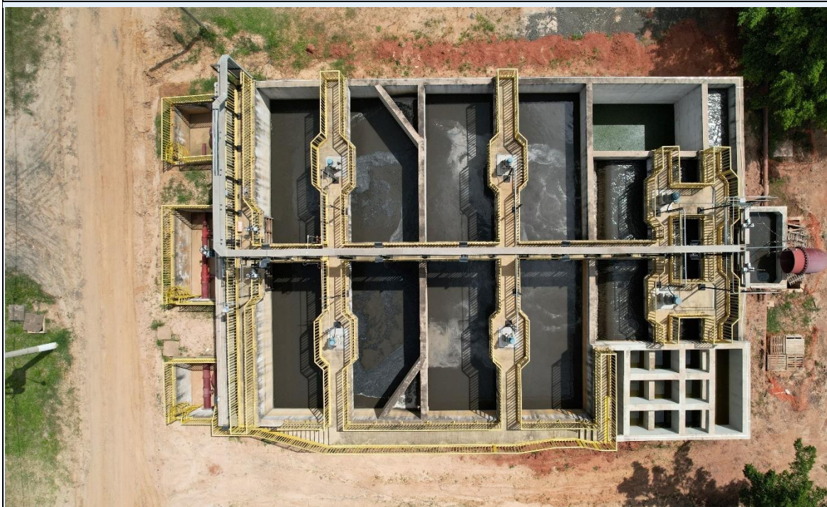
Figura 19: Imagem de drone do tratamento físico-químico (nov22)
