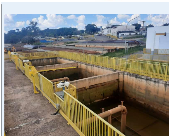
Figura 10: Tanques de adensamento
