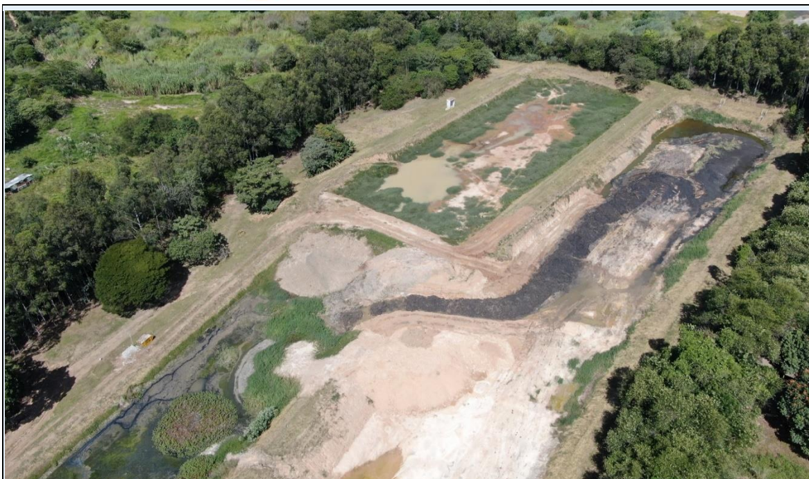
Figura 31: Imagem drone das lagoas (abr24)
