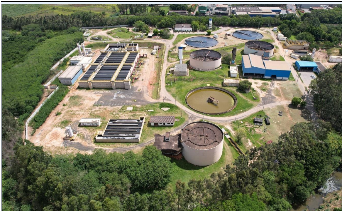
Figura 18: Imagem de drone ETE Tatu (nov22)
