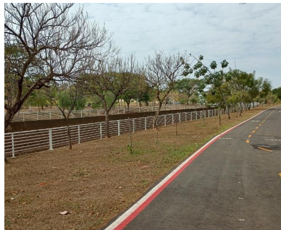
Foto 2 – PV do interceptor e recapeamento da ciclovia às margens do Rio Preto
