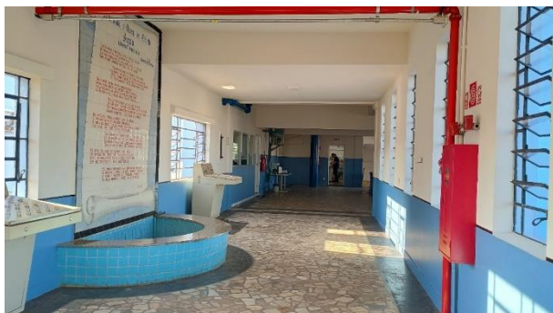
Foto 4 – Vista interna da ETA Palácio das Águas e preservação de elemento arquitetônico original da ETA.
