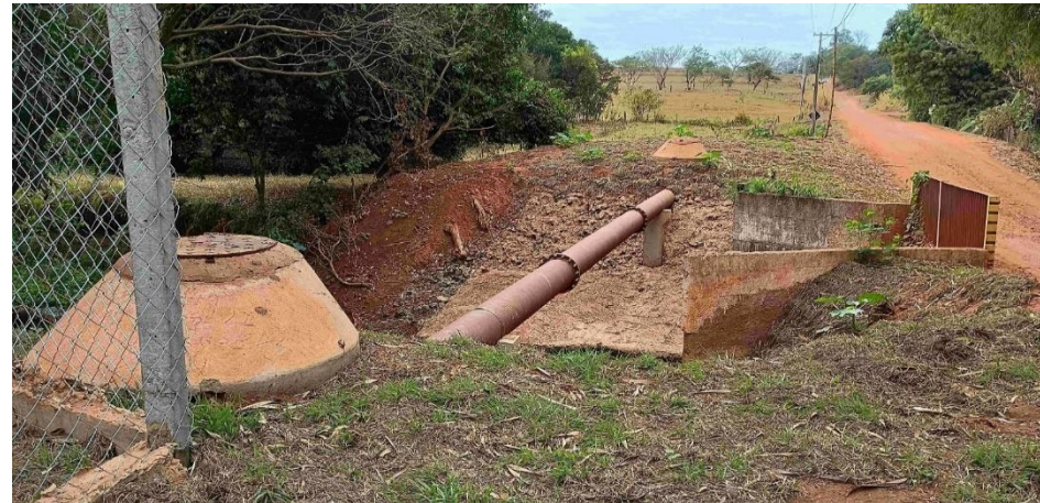
Foto 2 – Travessia aérea do interceptor.
