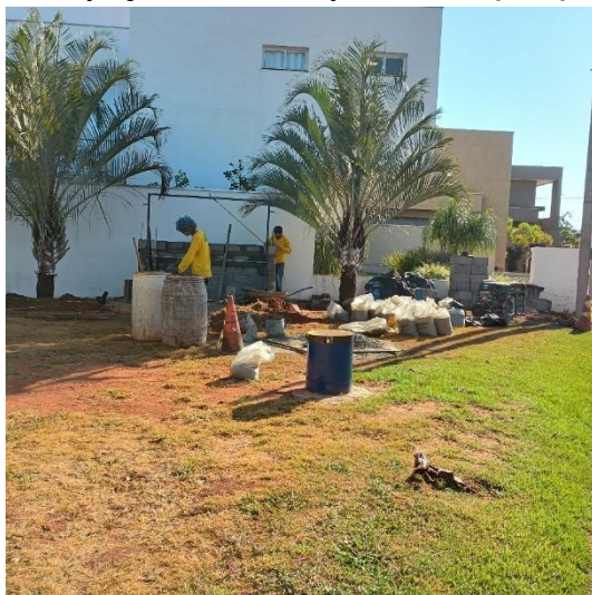
Foto 1 – Poço já perfurado (à frente) e construção do abrigo do painel elétrico e de comando ao fundo – Cond. Residencial Gaivotas II.
