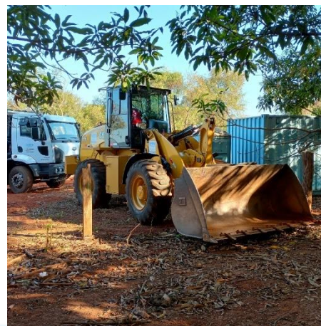
Foto 2 - Vista frontal da pá carregadeira em canteiro de obras do SeMAE.
