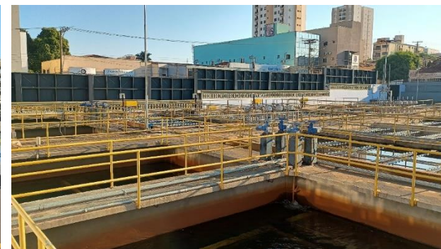
Fotos 2 e 3 – Estruturas de elevação de altura do muro da ETA e proteção contra eventuais lançamentos de materiais para o interior da ETA.
