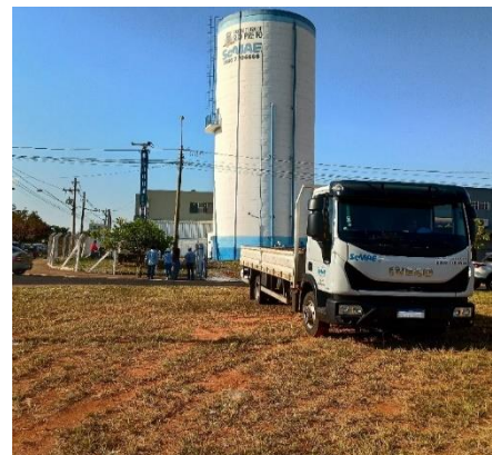
Foto 2 - Vista frontal do caminhão 4x2 do SeMAE e, ao fundo, poço tubular (PTB) e reservatório elevado.
