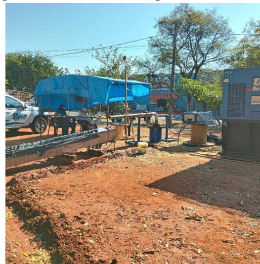
Foto 2 – Empresa contratada realizando testes no poço já perfurado no bairro Solo Sagrado.
