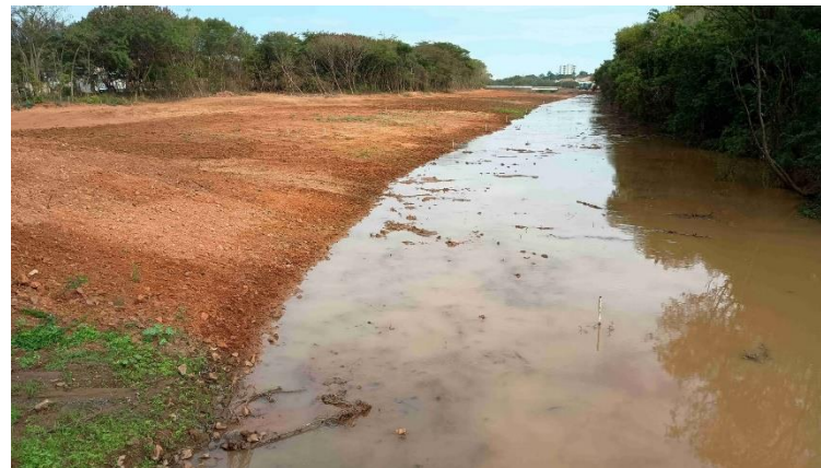
Foto 2 – Desassoreamento e ampliação da largura da calha do Córrego dos Macacos.
