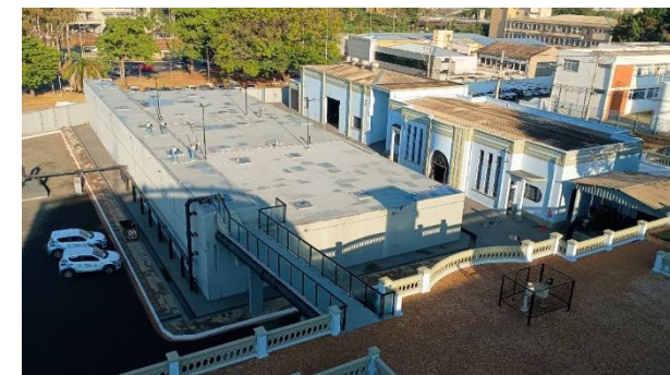
Foto 6 – Reservatório de água tratada e Estações Elevatórias de Água Tratada situadas dentro da área da ETA.
