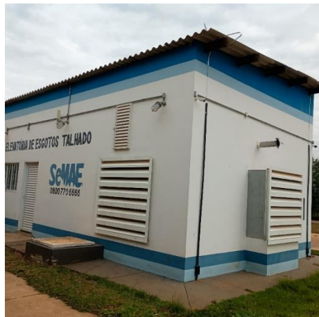
Foto 1 – Estação elevatória de esgoto Talhado.
