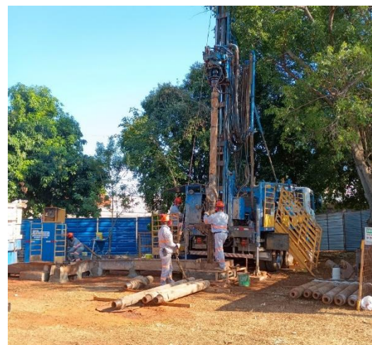
Foto 4 - Empresa contratada perfurando o poço no bairro Solo Sagrado.
