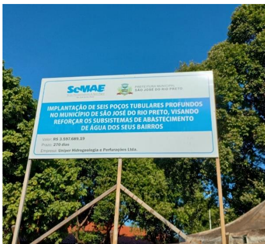
Foto 3 - Placa da obra no local da perfuração do poço no bairro Solo Sagrado.
