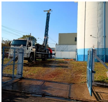
Foto 1 – Vista frontal do caminhão e carroceria adaptada para manutenção de poços em operação.
