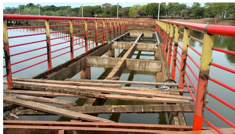
Foto 4 – Ponte sobre o Lago II da Represa em reforma após desassoreamento do Lago.
