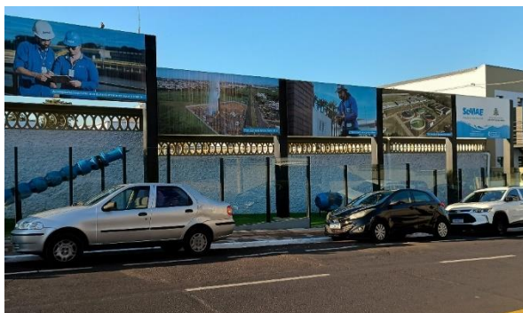
Fotos 2 e 3 – Estruturas de elevação de altura do muro da ETA e proteção contra eventuais lançamentos de materiais para o interior da ETA.
