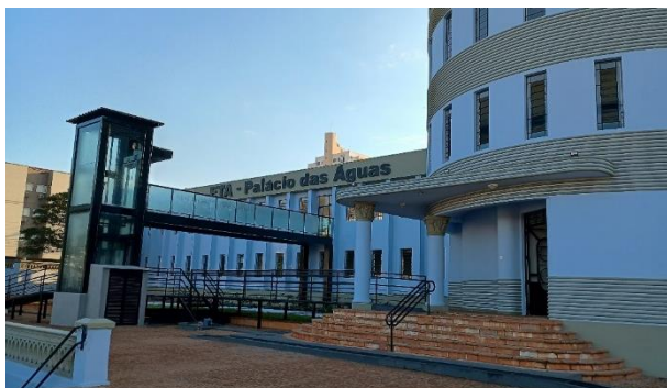
Foto 1 – Vista frontal da ETA Palácio das Águas.
