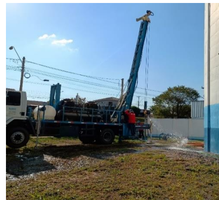
Foto 2 - Vista lateral do caminhão e carroceria adaptada para manutenção de poços em operação.
