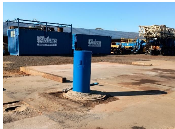
Foto 2 – Poço profundo PTG.
