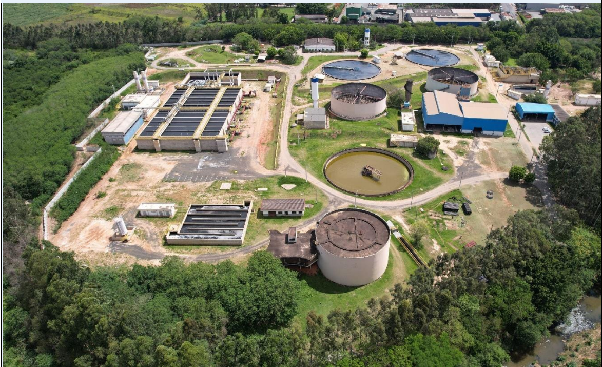
Figura 18: Imagem de drone ETE Tatu (nov22)
