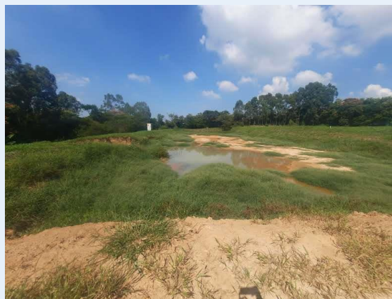
Figura 29: Vista da área raspagem de fundo das lagoas
