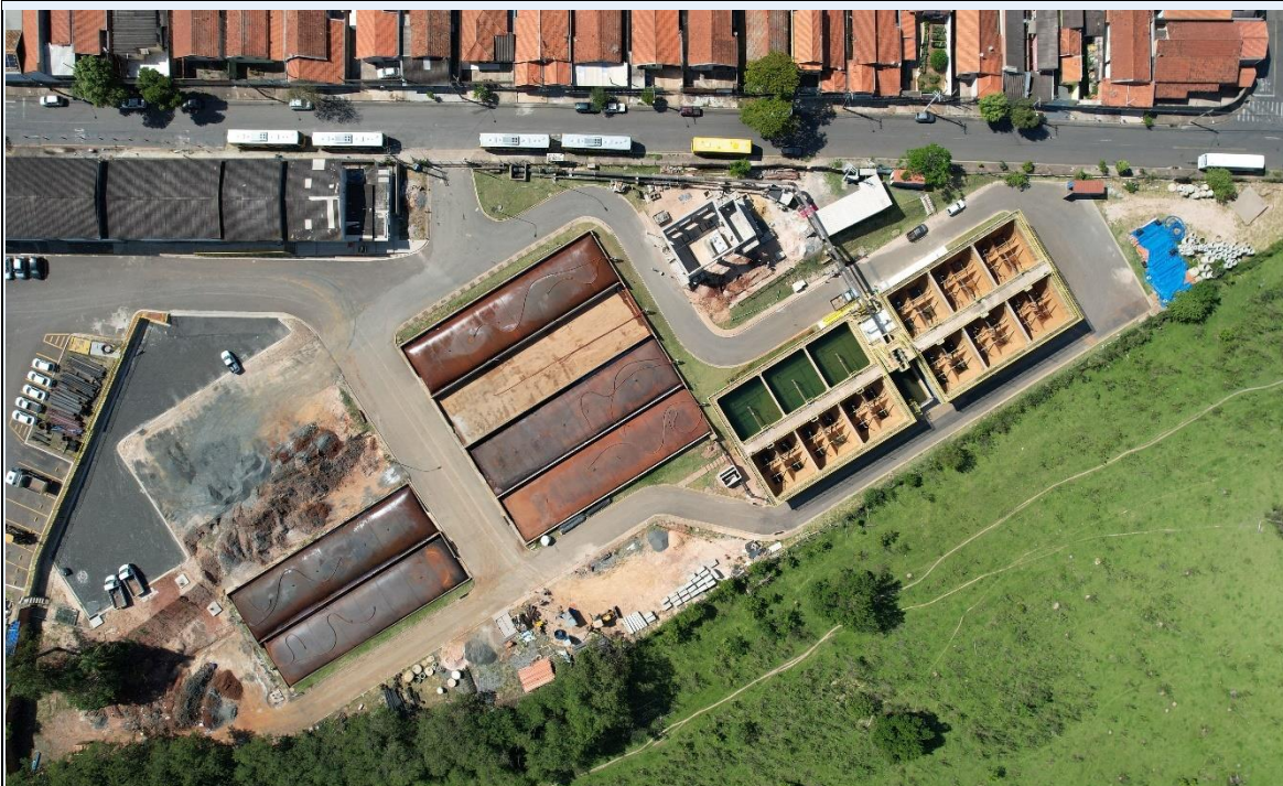
Figura 7: Imagem drone da Unidade da Tratamento de lodo da ETA (nov22)
