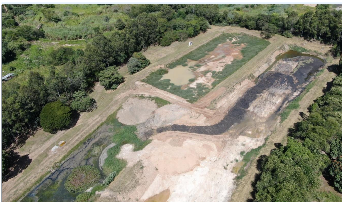
Figura 31: Imagem drone das lagoas (abr24)
