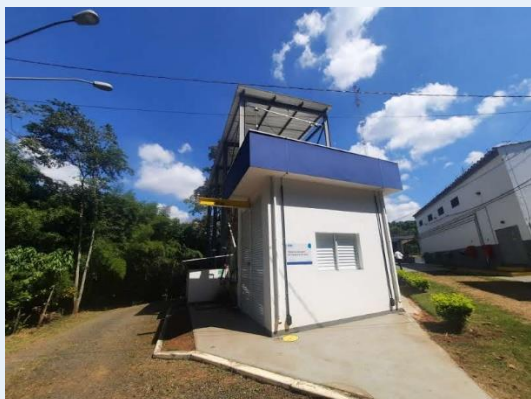
Figura 1: Sistema de dosagem de hipoclorito de sódio
