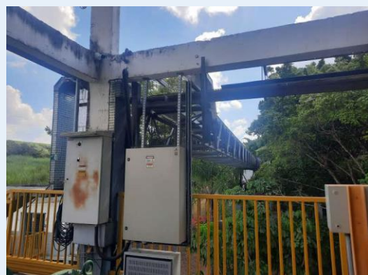
Figura 5: Melhorias elétricas realizadas na EEAB São Lucas
