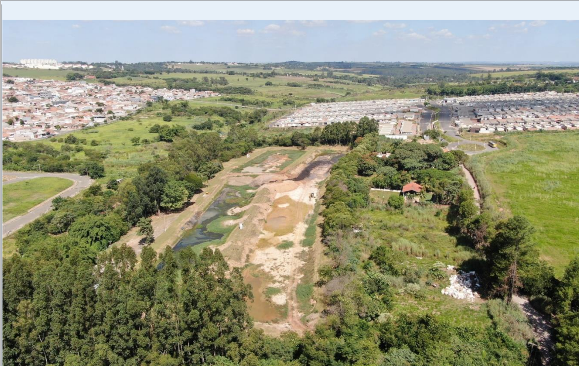
Figura 25: Imagem drone das lagoas (abr/24)
