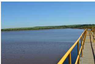
Reservatório João Ometto Sobrinho (Água Boa)
