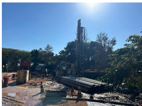
Foto 3 - Materiais e equipamentos para a perfuração do novo poço.
