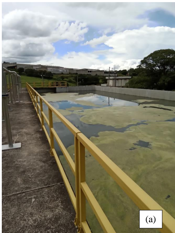
Figura TEC 3: (a) Guarda-corpos – segundo módulo de aeração da ETE Capuava (fev/2023) (b) Segundo módulo de aeração da ETE Capuava – aeradores operantes (fev/2023); (c) tubulação para interceptores (fev/2023);
