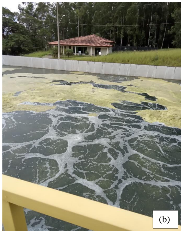
Figura TEC 3: (a) Guarda-corpos – segundo módulo de aeração da ETE Capuava (fev/2023) (b) Segundo módulo de aeração da ETE Capuava – aeradores operantes (fev/2023); (c) tubulação para interceptores (fev/2023);
