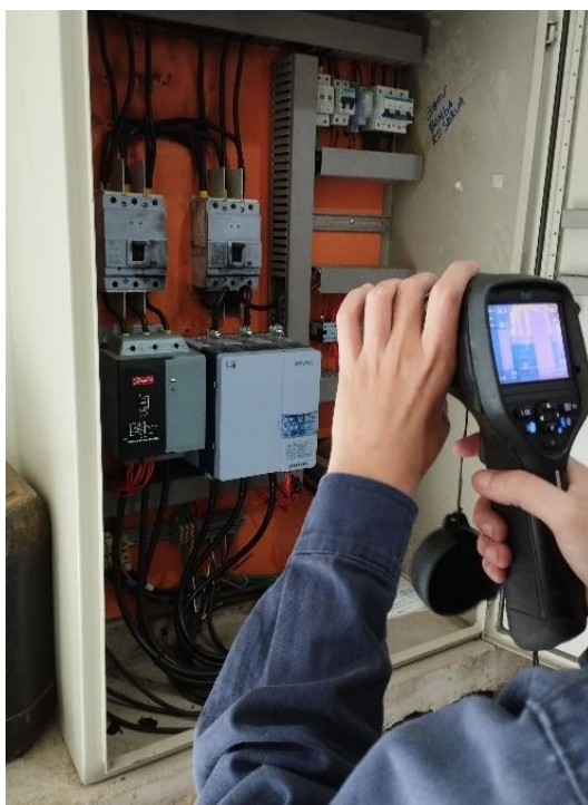
Figura 1. Inspeção termográfica em painel elétrico.
