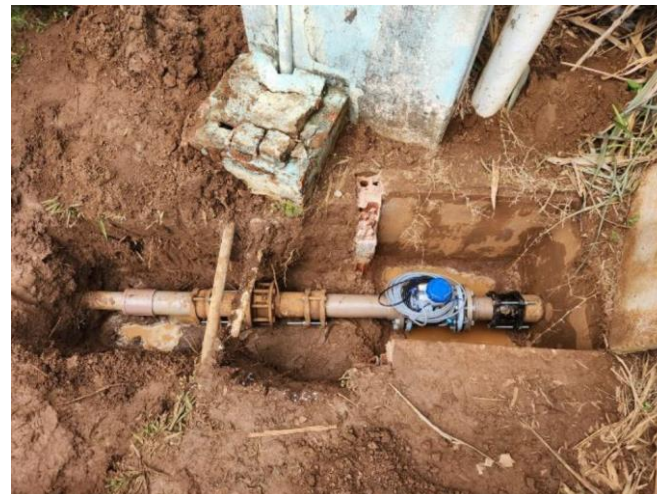
Foto 2 – Macromedidor instalado na EEAT Recalque do Distrito de Patrimônio (Fonte: Thesis Eng., 2024).
