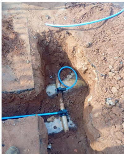
Foto 1 – Instalação de ramais e tê de serviço (Fonte: STA Soluções, 2024).
