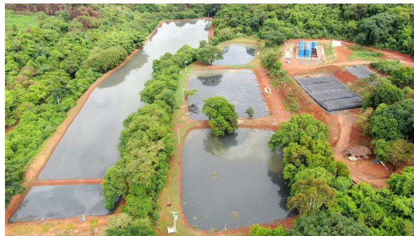
Foto 2 – Vista aérea da ETE Cidade, com a ETE Compacta na parte superior, à direita.
