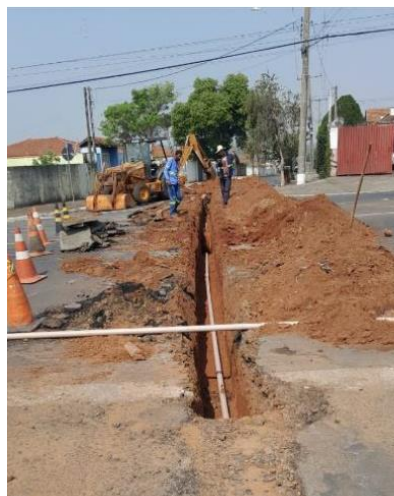
Foto 2 – Abertura de vala e implantação de novas tubulações (Fonte: STA Soluções, 2024).
