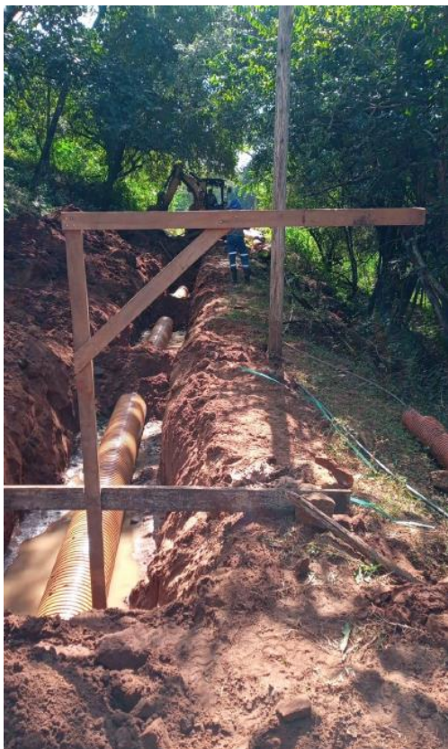
Foto 1 – Assentamento de tubulação ocre (Fonte: Octon Eng., 2024).
