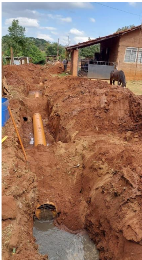
Foto 2 – Assentamento de tubulação ocre (Fonte: Octon Eng., 2024).
