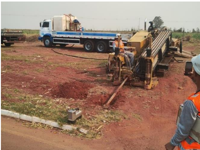
Foto 1 – Execução de rede por MND no Distrito de Patrimônio (Fonte: Thesis Eng., 2024)
