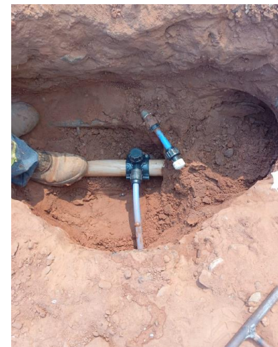
Foto 3 – Instalação de ramal e tê de serviço (Fonte: STA Soluções, 2024).
