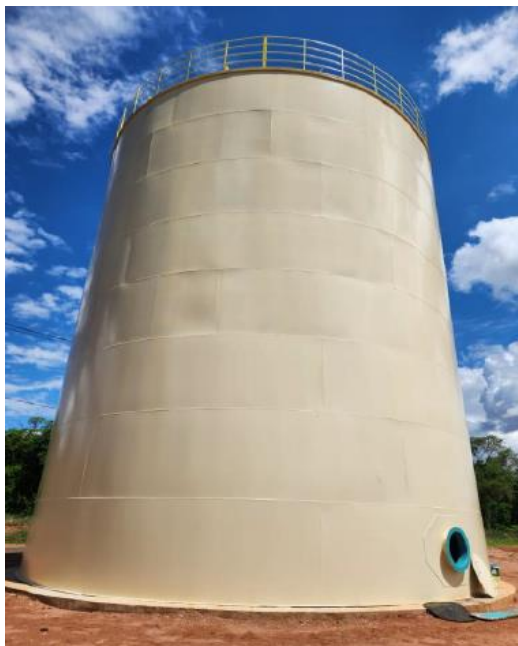
Foto 2 – Reservatório metálico instalado (Fonte: P-MON, 2024).
