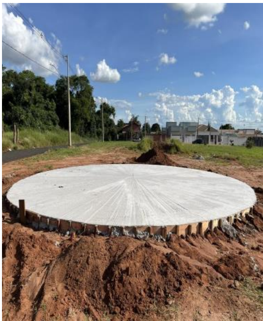
Foto 1 – Base do reservatório (Fonte: P-MON, 2024).
