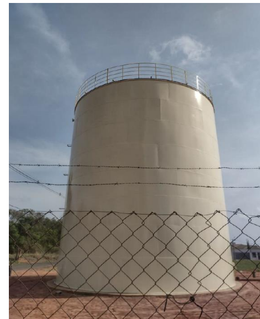
Foto 3 – Reservatório metálico instalado (Fonte: P-MON, 2024).
